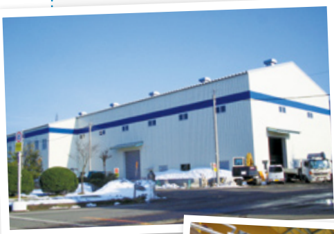
敦賀工場 (パイロットプラント)
