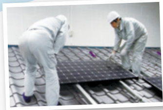
太陽光発電施工研修所での実習
