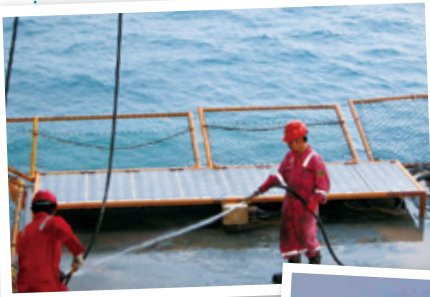
プラットフォームにおける太陽光発電施設（ベトナム）
